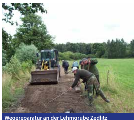
Wegereparatur an der Lehmgrube Zedlitz
