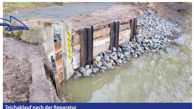
Teichablauf nach der Reparatur
