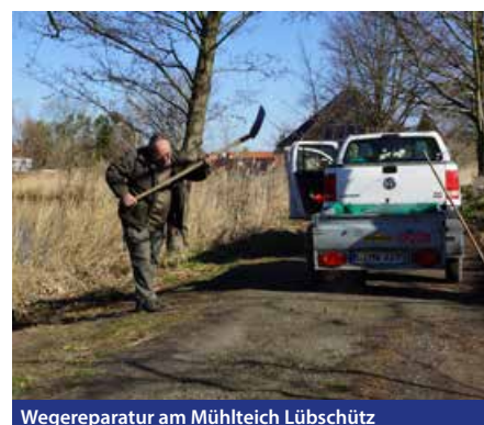
Wegereparatur am Mühlteich Lübschütz
