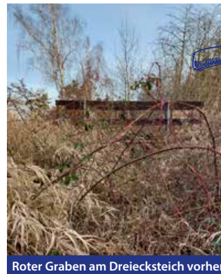
Roter Graben am Dreiecksteich vorher
